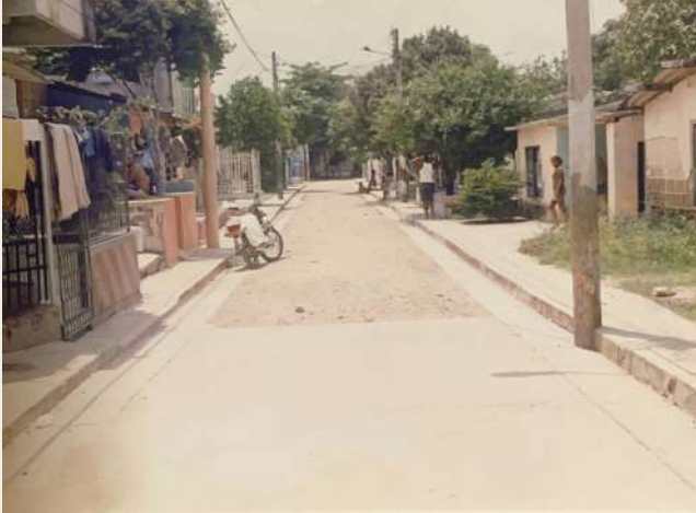
La pavimentación comunitaria es motivo de orgullo.
